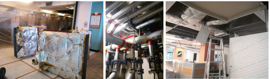
↑ 公館分館空調系統汰舊換新工程。
